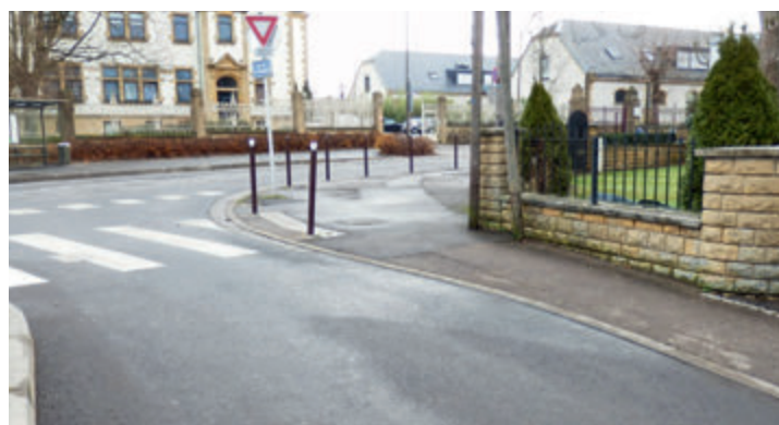
↑ Exemple à Plantières de suppression d'obstacles (bornes anti-stationnement) occasionnant une réduction de la largeur du passage sur le trottoir, remplacés par des potelets détectables (bicolores pour renforcer le contraste) occupant moins d'espace.
